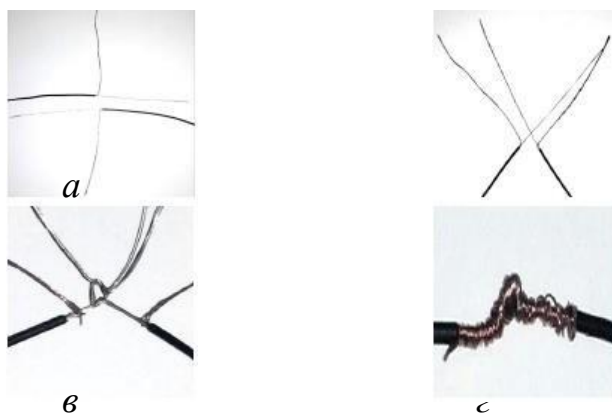
Рис. 9. Порядок виконання з'єднувальних скручувань
