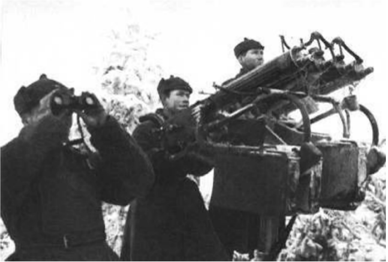
Повітряна оборона 30-х років. Зчетвернений кулемет "Максим" зі спеціальною туреллю (зазвичай на тачанці).
