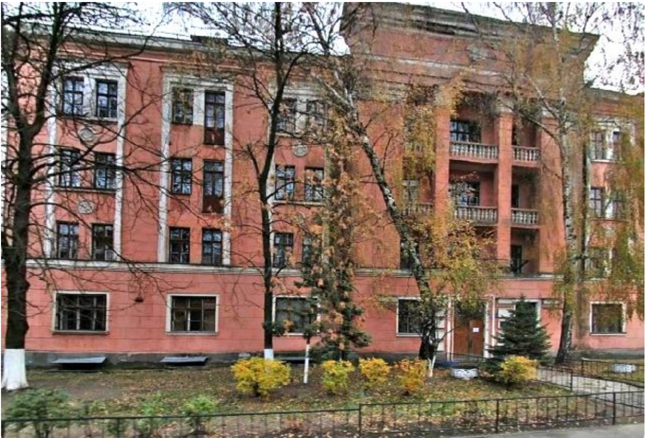
Будівля військової кафедри до 1982 року (м. Київ, вул. Клименка, 6/4)
