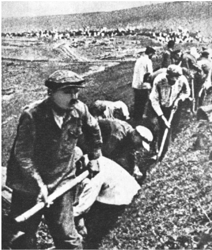
Співробітники Університету на будівництві оборонних споруд. 1941 р.
